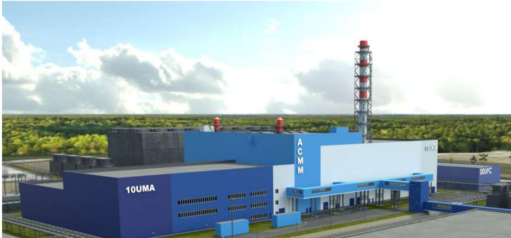
Главный корпус, состоящий из блока реактора, инженерных блоков №1, №2, спецблока с вентиляционной трубой, электротехнического и турбинного блоков, а также здание хранилища твердых радиоактивных отходов.
